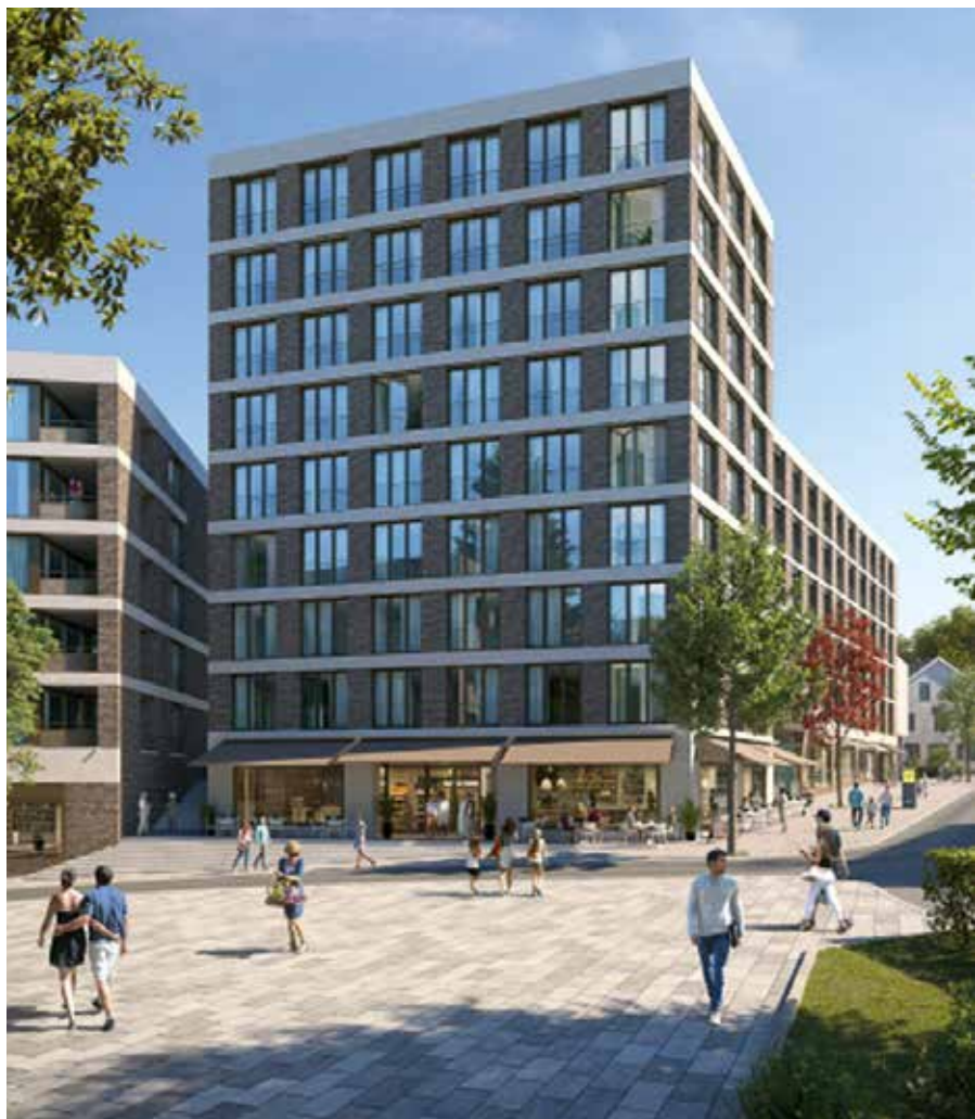
Nuova costruzione «Am Stadtplatz Kloten»: l'accumulatore di ghiaccio contorna da un angolo all'altro l'intero edificio (da davanti a destra a dietro a destra) e si trova a 7,5 metri sotto il livello del suolo.
