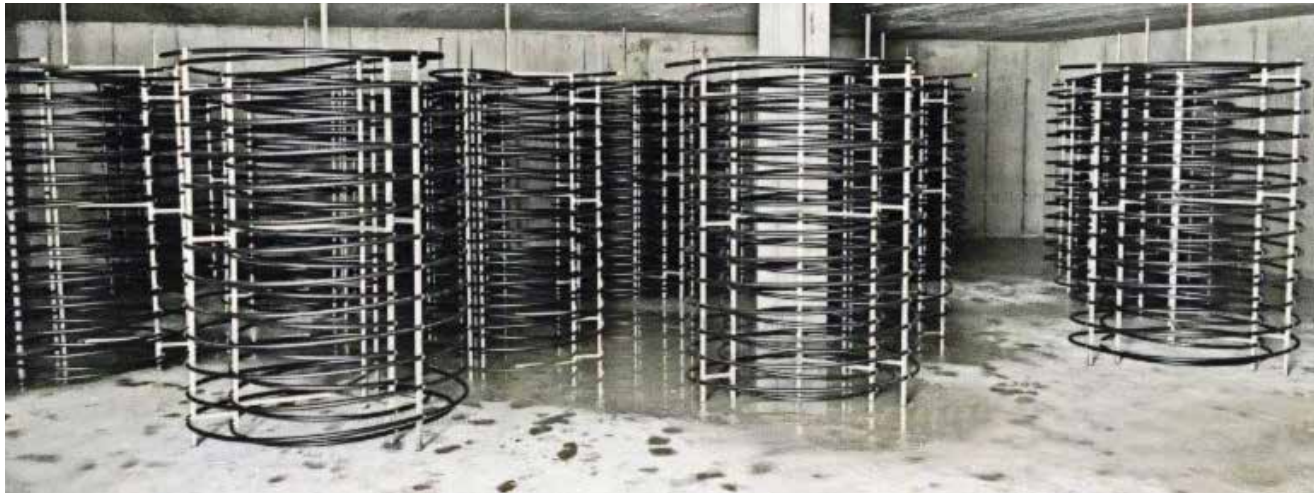
Lo scambiatore di calore nell'accumulatore di ghiaccio
