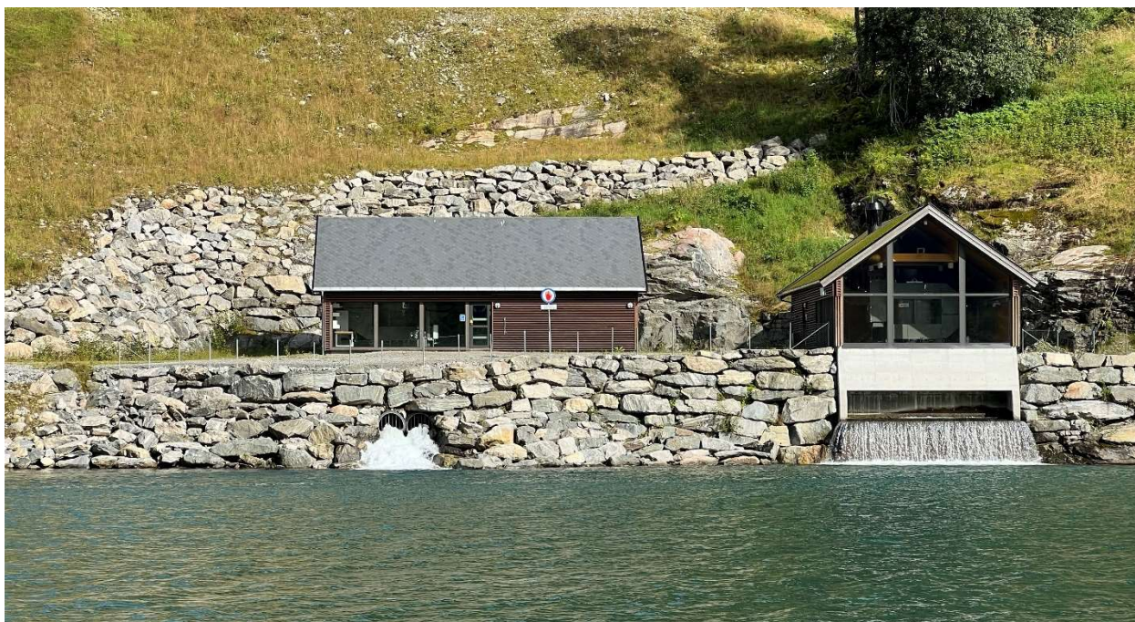
Centrale hydraulique à Grytneselva (Norvège)
