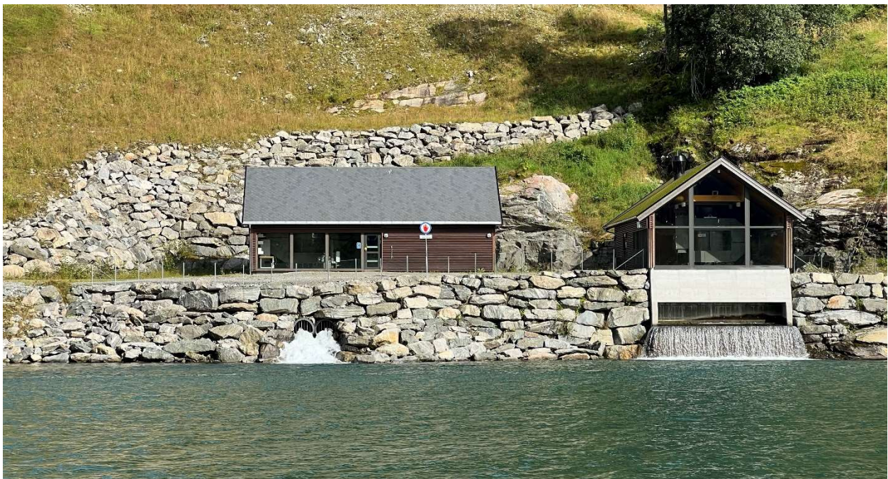
Wasserkraftwerk Ringdal (in Norwegen)
